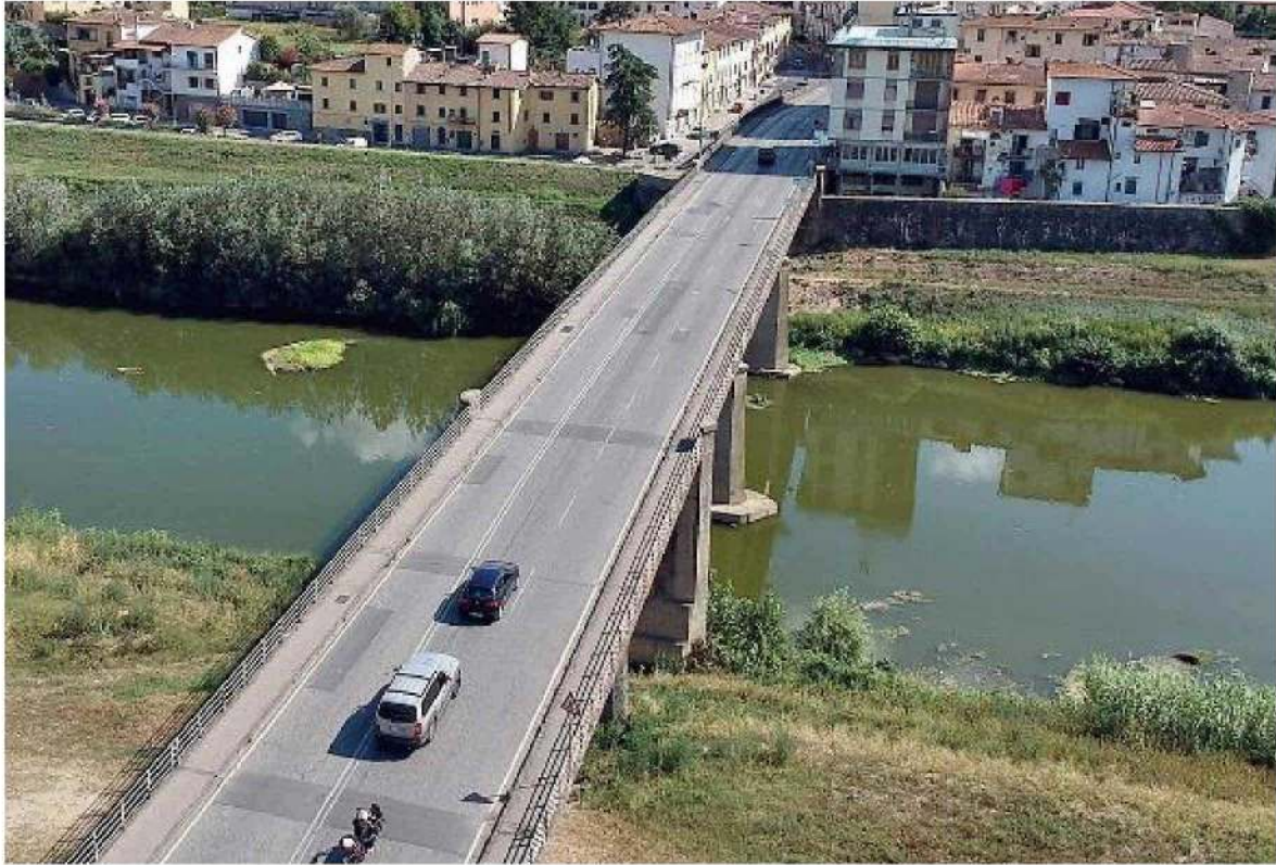
Il ponte tra Lastra e Signa, unico attraversamento tra il ponte all'Indiano e l'empolese. A destra, un dettaglio
