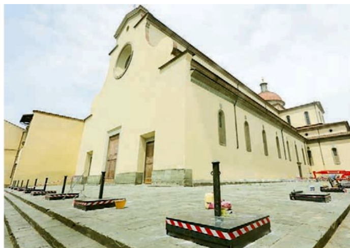
▲ La chiesa Il basamento del cordolo a protezione del sagrato
